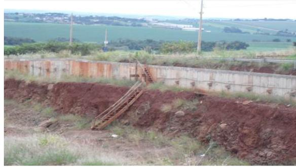
**Figura 04 – Contorno Norte - Escada de acesso à escavação em condições precárias**
