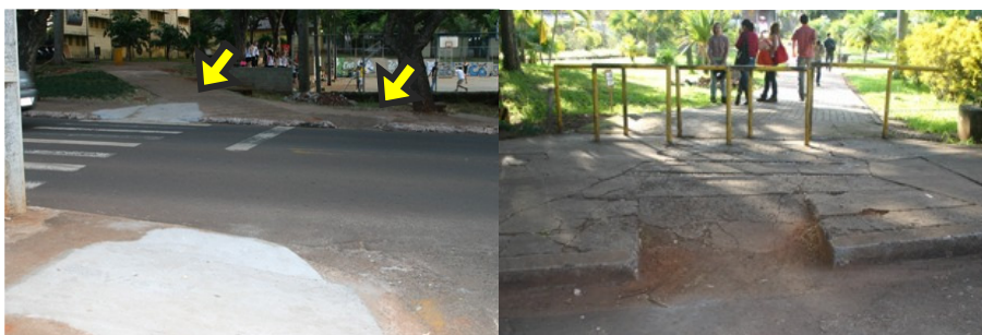
Figura 7 - Rampas de acesso
