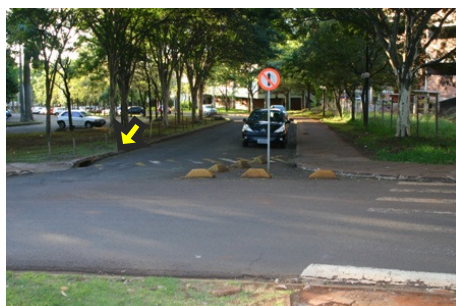
Figura 3 - Ausência de calçada em um dos lados da via
