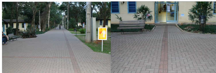
Figura 10 - Trecho com piso em ótimo estado de conservação
