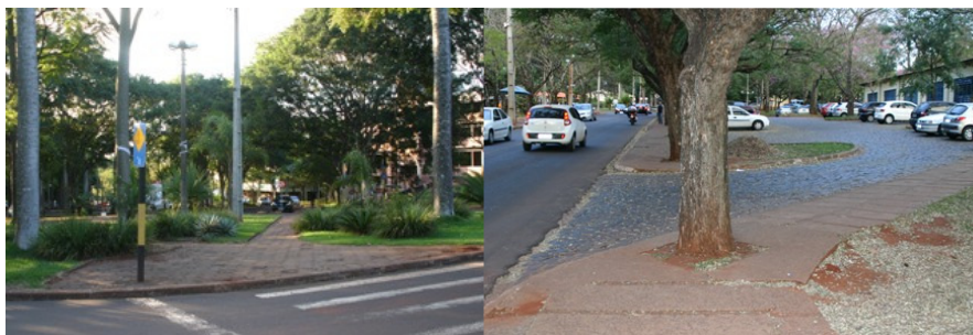
Figura 6 – Calçadas sem continuidade e rampas de acesso
