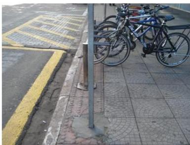
**Figura 21 - Paraciclo sobre o piso tátil de alerta**
