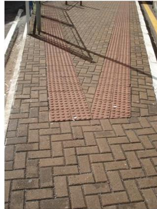
**Figura 8 - Entroncamento da sinalização sem respeitar a NBR 9050**
