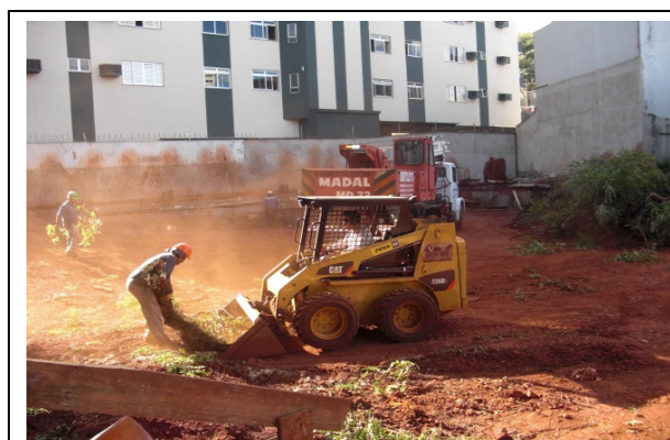
Figura 1 – Preparo do canteiro-de-obras
