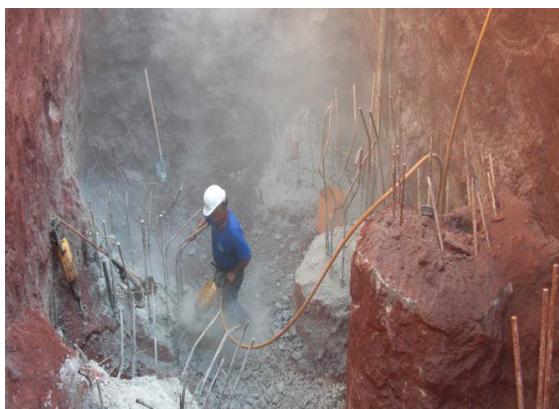
Figura 8 – Quebra da parte superior de tubulões com martetele pneumático
