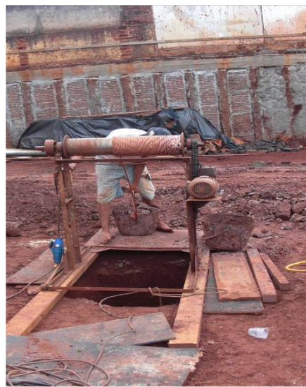
Figura 3 – Alargamento de base dos tubulões
