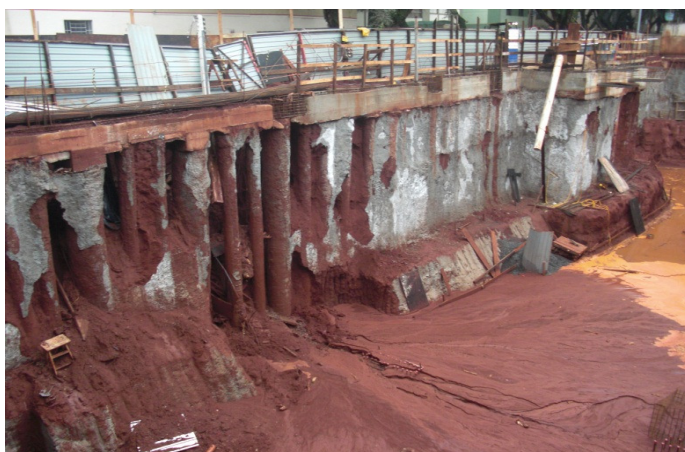
Figura 10 – Rompimento da canalização de água e esgoto da rede pública.
