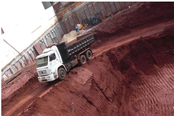
Figura 6 – Caminhão próximo ao talude
