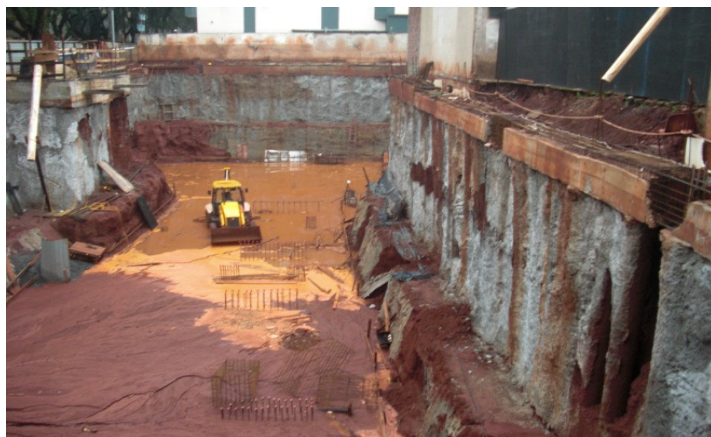
Figura 11 – Local alagado por despejo de esgoto e água da rede urbana.
