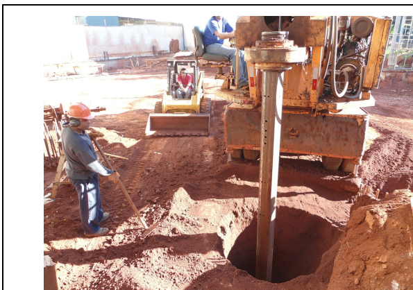
Figura 2 – Perfuração do Fuste de Tubulões
